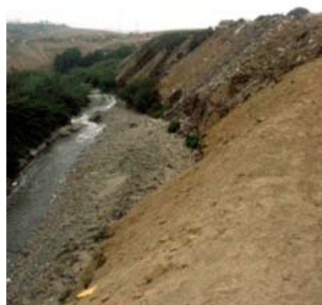
Foto N.º 14. Se observa las huellas de la erosión lateral del río Chillón, además de materiales y basura arrojados por los pobladores.
