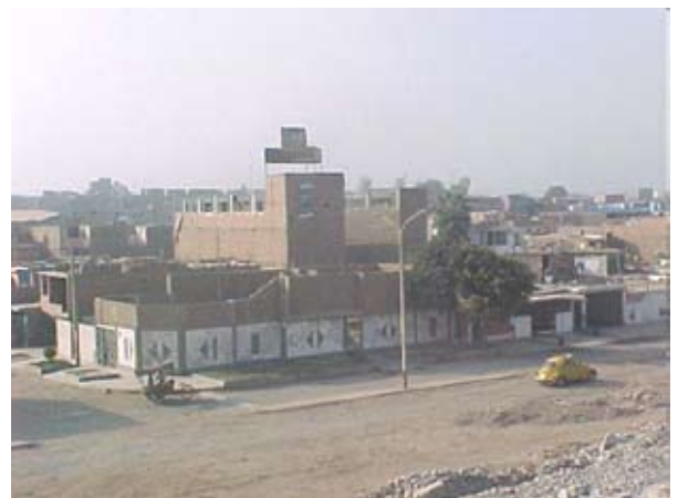
Foto N.º 10. Obsérvese las mismas calles que la anterior foto, para tener en cuenta la magnitud de la inundación.
