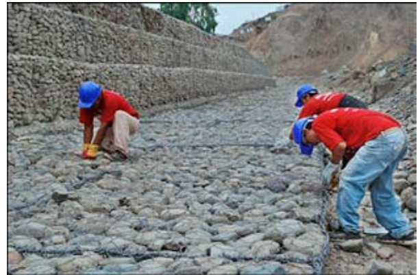
Foto N.º 19. Gaviones y colchones antisocavantes, con contenedores de piedras retenidas con malla de alambre. Margen izquierdo del río Chillón tendrá un largo de 783 m.
