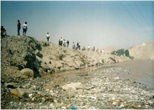
Foto N.º 5. Se observa como eran las defensas; estas colapsaron con el caudal y fuerza del río Chillón.
