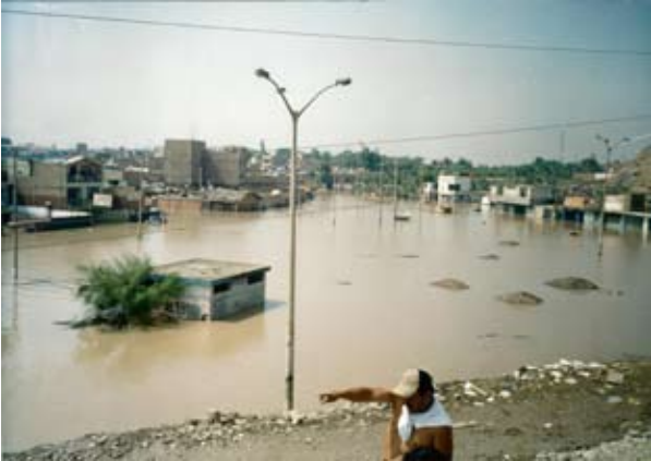
Foto N.º 11. Foto aérea donde se observan los terrenos y casas alcanzadas por la inundación.
