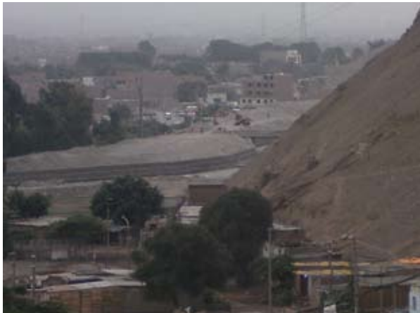
Foto N.º 20. Se observa los gaviones, si bien es cierto es una defensa para evitar la inundación a San Diego hacia la margen izquierda, pero la margen derecha también está siendo habitada por los pobladores y pueden ser inundadas.
