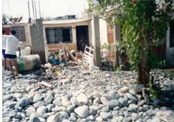
Foto N.º 12. El río trajo consigo abundantes cantos rodados como se observa cerca de esta casa.
