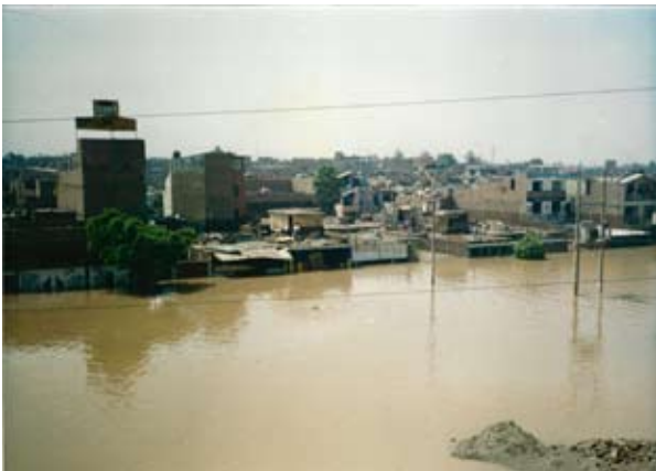
Foto N.º 7. La inundación ocupó la geoforma de hondonada, afectando a la población.
