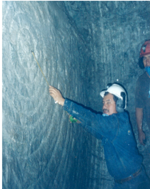
Fotografía N.º 2. Frente de excavación en roca dura.
