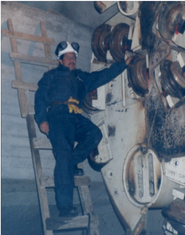
Fotografía N.º 1. Cabezal de la TBM MK 12 en fase final de montaje.
