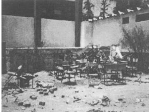
Foto N° 7. Área donde se observan las carpetas en estado de oxidación, afectando el suelo y dando mal aspecto
