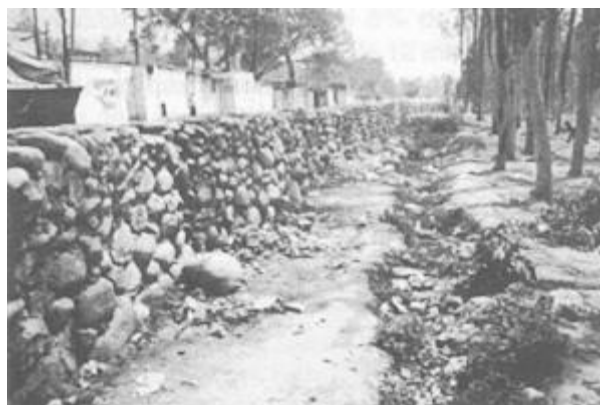
FOTO N° 12. La suciedad detrás de los kioscos le resta imagen exterior a la Universidad . Es necesario su reubicación.
