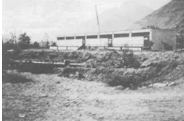
FOTO N° 10. Aulas en Facultad de Humanidades y tubería de agua potable en el mismo cauce del huayco. Es necesario una defensa adecuada o reubicación.
