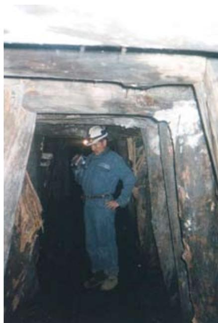
Foto 5. Galería principal de una mina informal de carbón en peligro de colapso y subsidencia.
