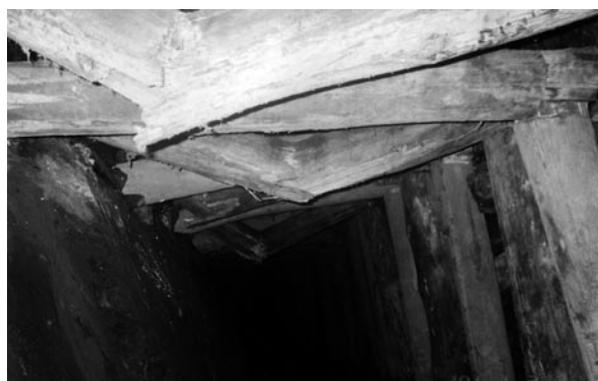
**Foto 3.** Galería principal de una mina de carbón, donde los sombreros de los cuadros están completamente fracturados y rendidos a punto de producirse la subsidencia de la galería.
