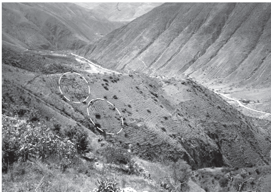
Foto N.º 6. En Mesapata Bajo se observan dos pequeños deslizamientos en los terrenos asignados al Sr. Eleuterio Martel, quien regó en exceso, originándose el deslizamiento de origen netamente antrópico. Actualmente el área es estable y está siendo cultivada. Asimismo, el comunero ha aprendido la lección: «regar de manera racional».
