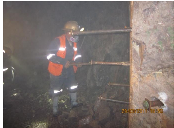
Foto N° 4-2: Instalación de los Hydrabolts
