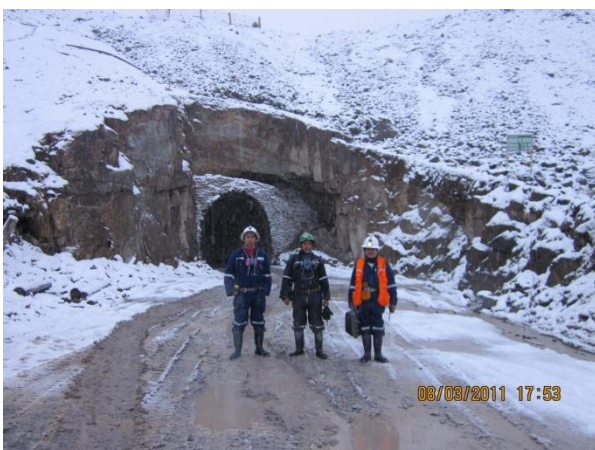
Foto N° 1-1: Portada del Nv 642, ingreso al crucero 752
