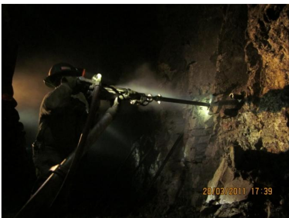
Foto N° 2-1: Instalación de un Split Set.
