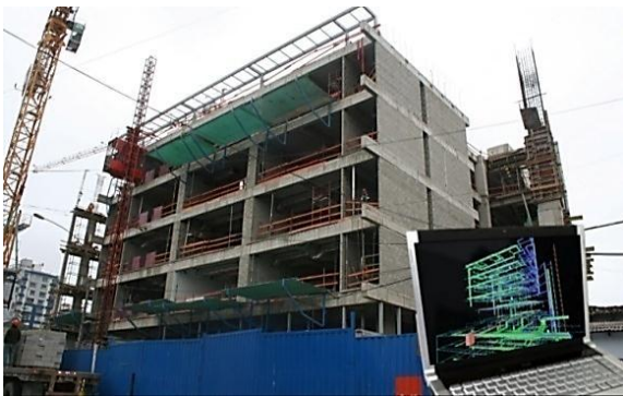
Figura 6. El BIM es una representación virtual y tridimensional de los componentes de la edificación, al nivel de detalle que se requiera. (Foto: Nuevo edificio de la Universidad del Pacífico - GyM)
