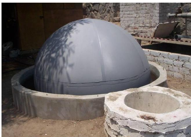
**Foto N°1. Biodigestores con cúpula de geomembrana PVC**
