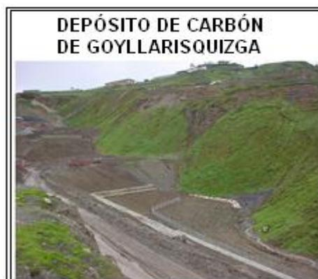
El método de explotación era el Long Long Wall o Tajeos Largos con recuperación de pilares, el carbón era extraído por el inclinado principal, el cual era jalado con una wincha, la mina contaba con puertas de separación interna para seguridad las cuales se cerraban una vez ingresado el personal con el fin de asegurar accidentes por posibles explosiones del gas grisú o el polvo de carbón que se encuentra en el medio ambiente.
