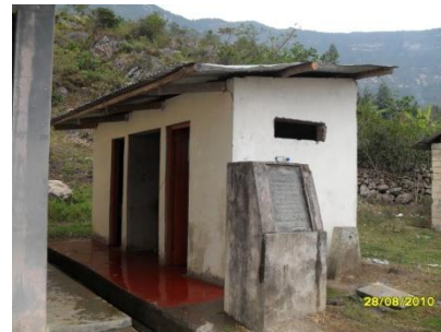
Figura N° 15.- Servicios Higiénicos a la entrada de la Catarata del Gocta
