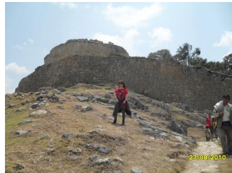
Figura N° 4.- Visita Técnica a la Fortaleza del Kuélap
