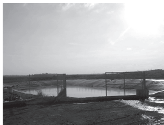
Figura N.º 6. Reservorio de efluentes utilizado para la fabricación de compost-Shacham Givat Ada.
