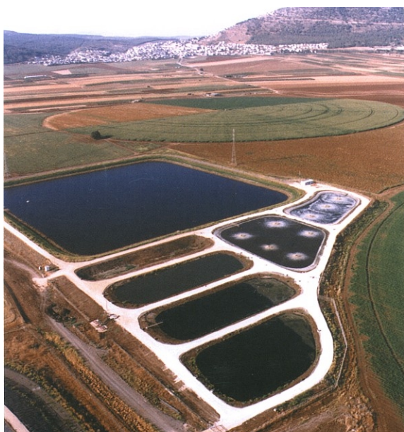
Figura N.º 4. Vista panorámica de un PTAR basado en unidades semiintensivo y reservorio profundo.
