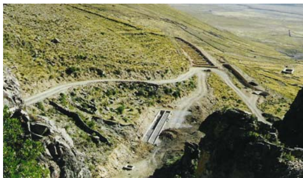
Fotografía de las instalaciones del fango artificial en el terreno.
