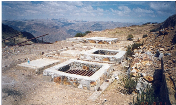
Foto N.º 4. Muros de protección de Raise Boring clausurada.
