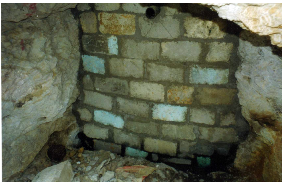
Foto N.º 1. Clausura de galería con bloquetas de concreto.
