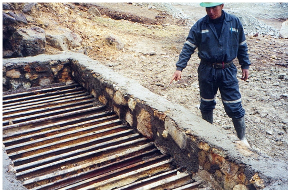
Foto N.º 3. Chimeneas clausuradas con parrillas de rieles en Mimosa.
