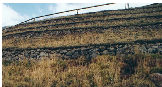
Foto N.º 7. Vista de la revegetación de las canchas de desmontes.
