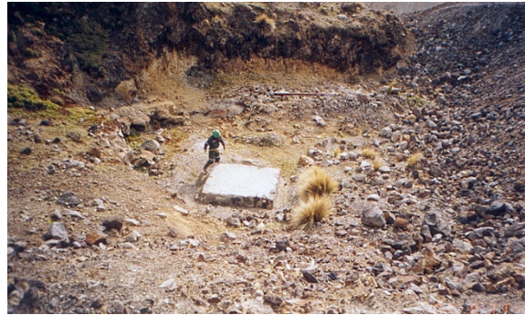
Foto N.º 5. Tapón de concreto de chimenea en zona de Mimosa.
