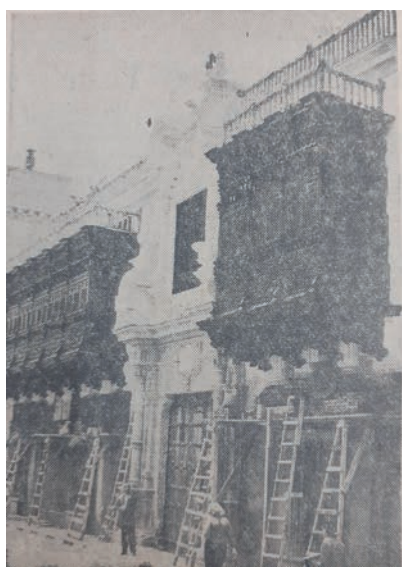
Figura 10. Vista de los trabajos realizado en los balcones, 1958.
