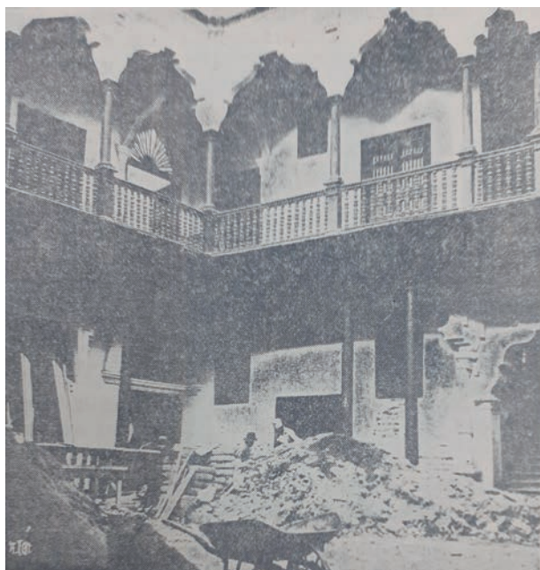
Figura 8. Vista de los trabajos en la primera planta, 1955.
