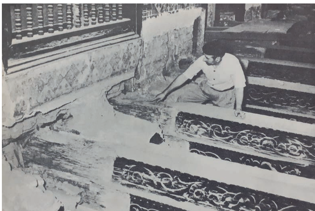
Figura 12. Reforzamiento de las vigas deterioradas, 1958.
