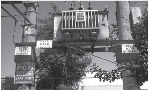
Figura 4. Transformador conteniendo PCB (Corresponde a un sistema completamente cerrado)
