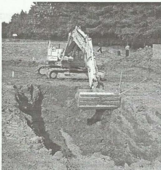
Figura N.º 1. Detalle de los trabajos para descubrir la tubería que conduce gas natural, luego de ubicado el defecto del revestimiento de la tubería que conduce gas. Cortecia del Centre Belge d'Etude de la Corrosion.
