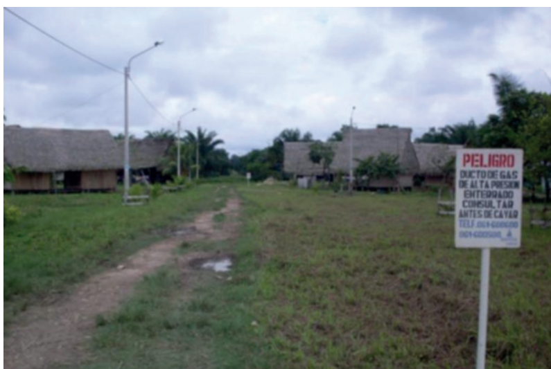
Figura 4. Viviendas y postes de alambrado aledaños al Derecho de Vía de un ducto de gas natural Ducto de gas natural operado por la empresa Aguaytia energy (Archivo Osinergmin).
