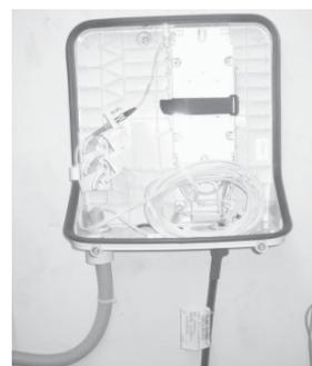
Figura 7. Conexión óptica en cada red LAN.
