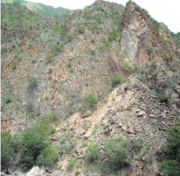
Derrumbe próximo al anterior. Foto DDC.
