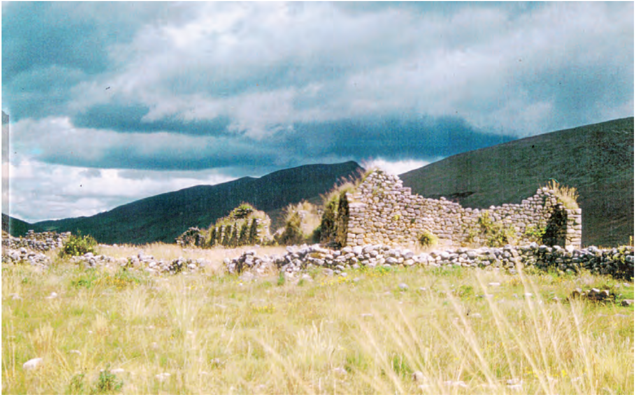
Fig. 7. Kallanca de Huánuco Pampa. Una de las más extensas y mejor conservadas. Estructura arquitectónica con fines militares (Foto H. Amat).
