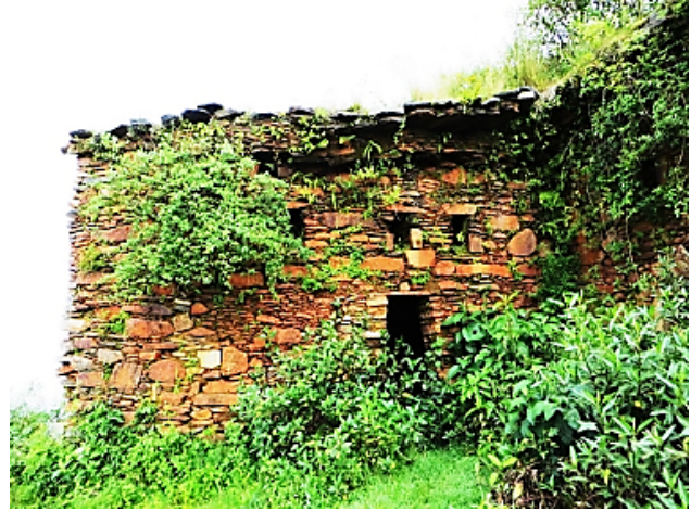
Foto 10. Sitio Gorish; Cultura Yarush Intermedio Tardío. Edificio en planta rectangular emplazado en el Sector A, donde apreciamos la técnica constructiva cuya estereotomía presenta piedras medianas intercaladas por pequeñas lajas planas asentadas por segmentos a lo largo y ancho de los paramentos externos e internos. El vano de elevación vertical tiene como ornamento tres pequeños nichos también de elevación vertical, rematando en una cubierta a base de numerosas lajas extendidas que terminan en un voladizo al exterior. El edificio presenta cubierta vegetal natural.
