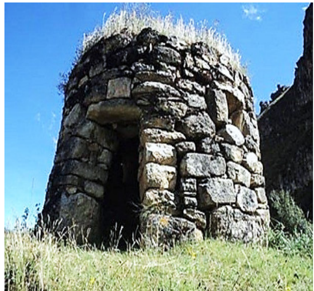
Foto 11. Sitio Gorish; Cultura Yarush Intermedio Tardío. Edificio en Planta Circular en superficie con otros ejemplares similares, en cuyo tercio medio norte presentan un vano alto proveedor de aire al interior; notar el vano céntrico de construcción muy sólida. Su cubierta está construida a base de vigas líticas largas sostenidas en los lados de los muros, para dejar un techo circular.
