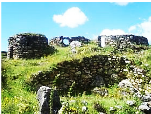
Foto 12. Sitio Gorish: Cultura Yarush Intermedio Tardío. Edificaciones en planta circular sobre una terraza a base de piedras asentadas con barro. De las tres unidades que observamos, sólo una está conservada; las otras dos, al parecer, han sido afectadas por descarga de rayos, fenómeno que ha terminado por hacer saltar lejos las piedras que eran componentes de los muros arqueológicos.
