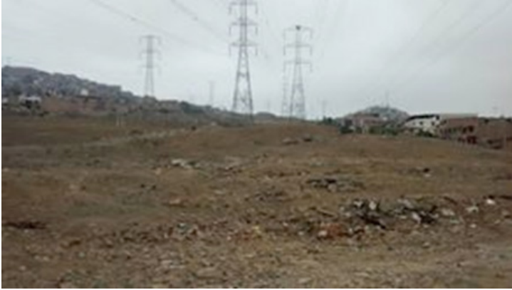
FOTO 1. Espacio del tendido de los cables de alta tensión de REP.
