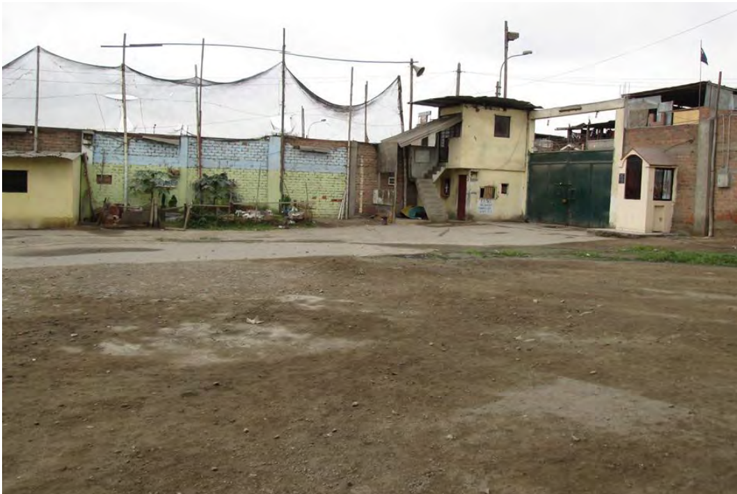
FOTO 2: Espacio que era destinado al alquiler de la cochera.
