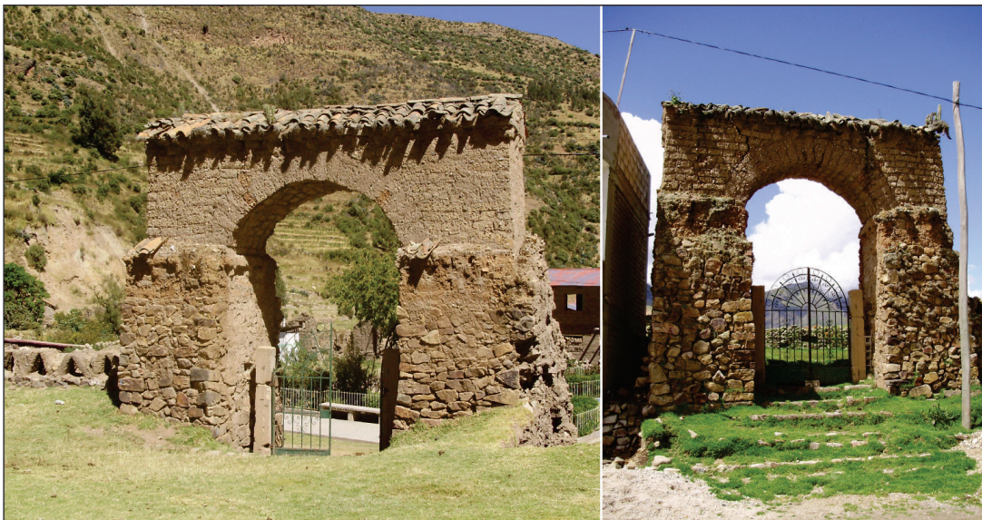
Fig. 5. El arco original de piedra y adobe, en cuyos peldaños superiores de la escalinata se ubicaban los litografados
