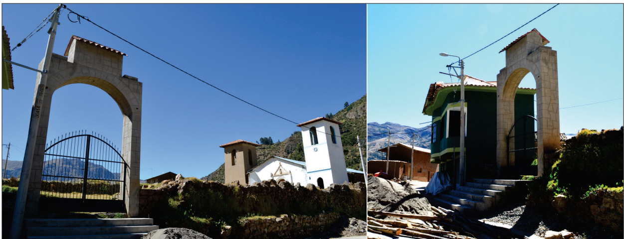
Fig. 6. El arco y la escalinata de concreto que reemplazaron a las estructuras originales de la época colonial
