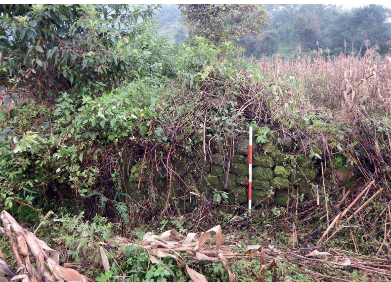
Fig.4. Muro de pirca en uno de los edificios de Purumllaqta de Cuimal.
