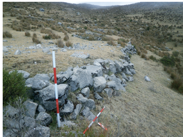
Figura 15. Vista lateral de muros de contención que forman parte de los andenes ubicados al pie del sitio arqueológico Llaqtaqasa.
