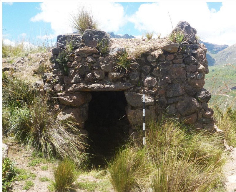
Figura 7. Ejemplo de una estructura techada en el sitio de Chipaomarka, valle de Mayobamba, Chipao.
