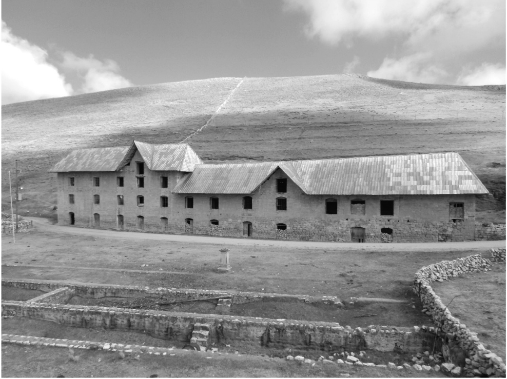
Fig.2 Vista de la fachada de la Casona de San Blas. (Fuente: Archivo Personal)
