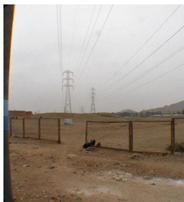
Figura 5. Cerco destruido y torres de alta tensión (Fotografía: C. Jaime).
