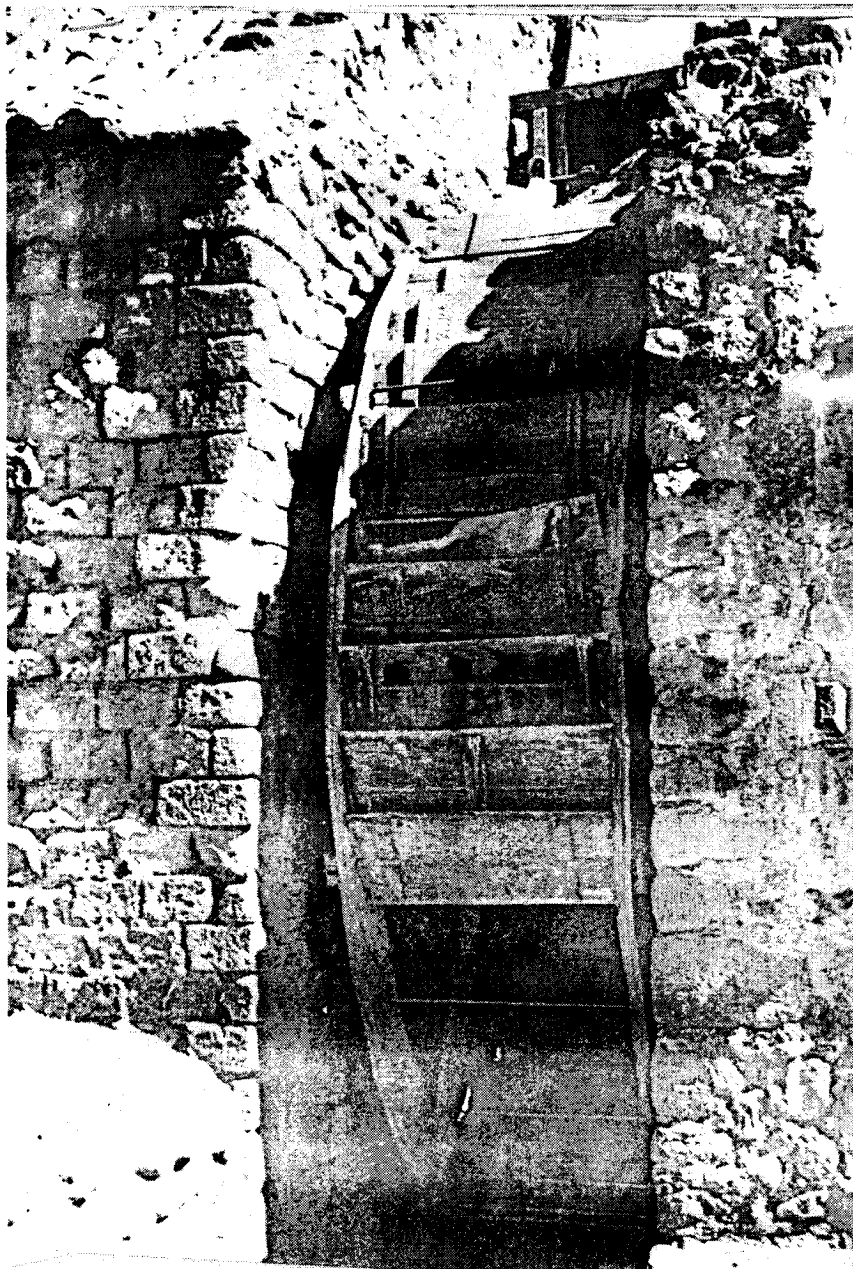
Fig.2. Fotografía de la rueda de un molino hidráulico de Potosí, inserta entre las dos paredes de su cárcamo o castillo. Se aprecian las paletas acajonadas y, en la parte superior, el vertedero del agua que impulsaba la rueda y su eje central, observable en la siguiente figura.
