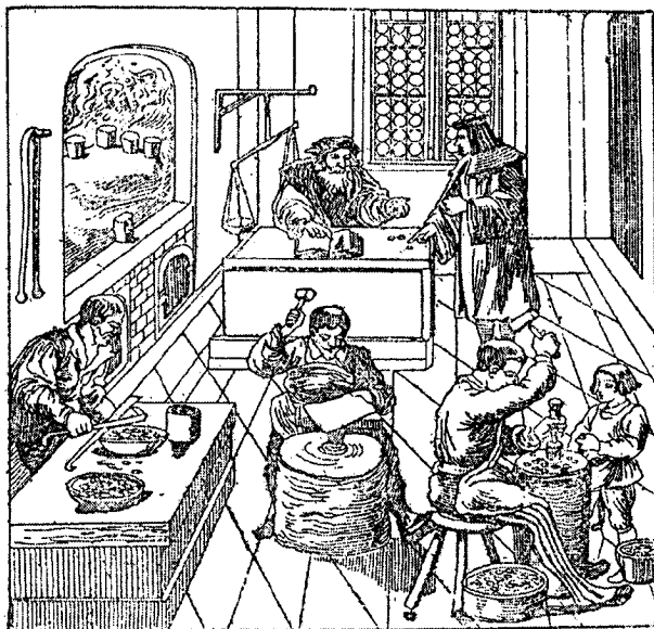
Fig. 7. Detalle de un grabado mostrando las actividades que en las cecas coloniales se llevaban a cabo en la hornaza y en los bancos de acuñación.
