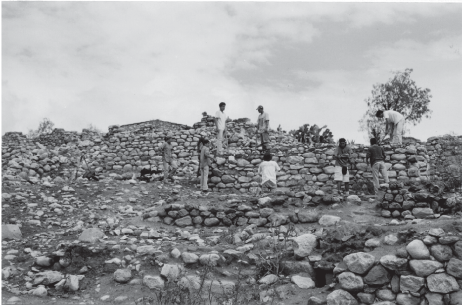
Foto 1. Alumnos de la UNMSM en pleno trabajo de demolición de las casas de los ocupantes precarios en Tumshukayko, 2004.
