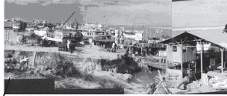
La "Costa Brava" socava el margen izquierdo; la Bomba de agua se moviliza en función a la corriente del río
