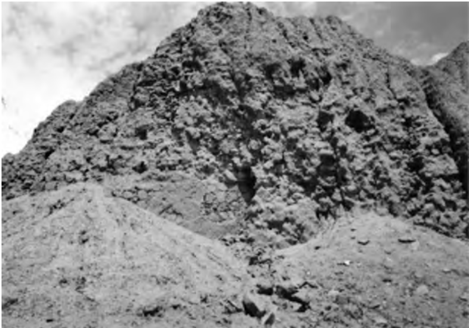
Sitio Arqueológico Menocucho, distrito de Laredo, provincia de Trujillo, La Libertad. Las lluvias erosionan y convierten en barro a los adobes de las construcciones arqueológicas.
