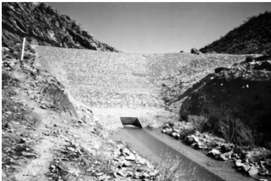
Laguna Shallap. Dique construido sobre morrenas laterales a fin de controlar un probable desborde de la referida laguna.
