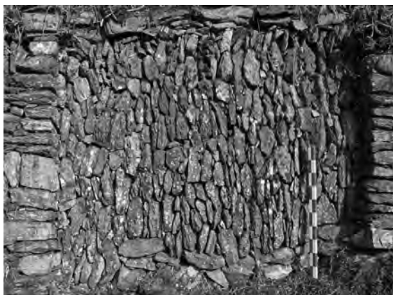
Figura 7. Muro con aparejo hecho de micaesquistos de formas irregulares. Sector VIII de Choquequirao.
