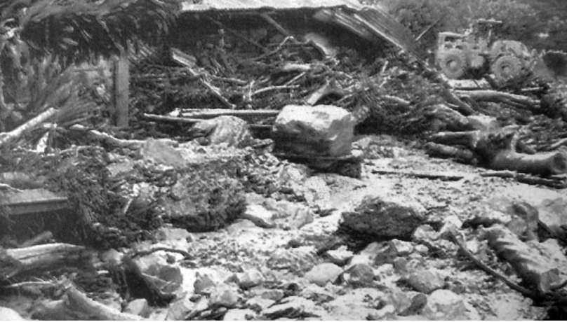
El pueblo Nuevo Progreso destruido por el flujo torrencial (La República 18/10/2012).
