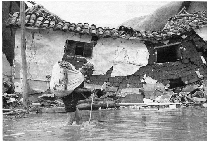
Casa afectada por el flujo torrencial (Foto: La Primera).
