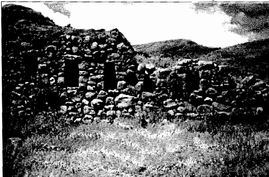
Foto 2: Sección del muro este del cuadrángulo de los nichos conservando algunos completos y otros desplomados.
