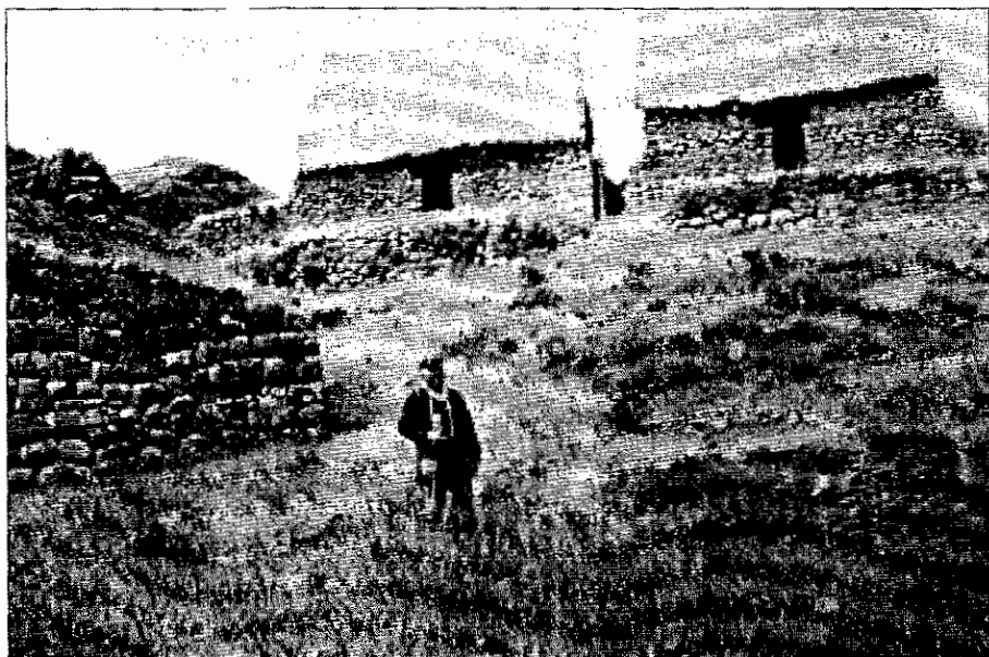
Foto 3: Vista frontal de las dos casas con techos restaurados. Ver la separación con un gran vano trapezoidal de doble jamba construido en base a piedras labradas finas.
